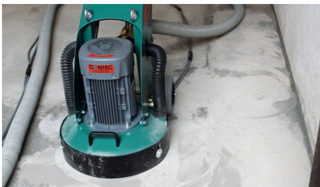
Bild 2: Estrichschleifmaschine (Quelle: contecgmbh.com)
